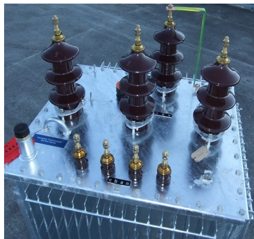
15A P-spole og 100kVA Transformator 22000+-2x2,5% /415 V ZNzn0
