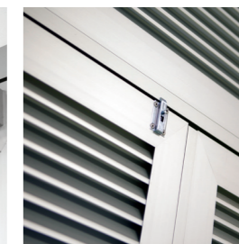
Lås oppe av sidedør
