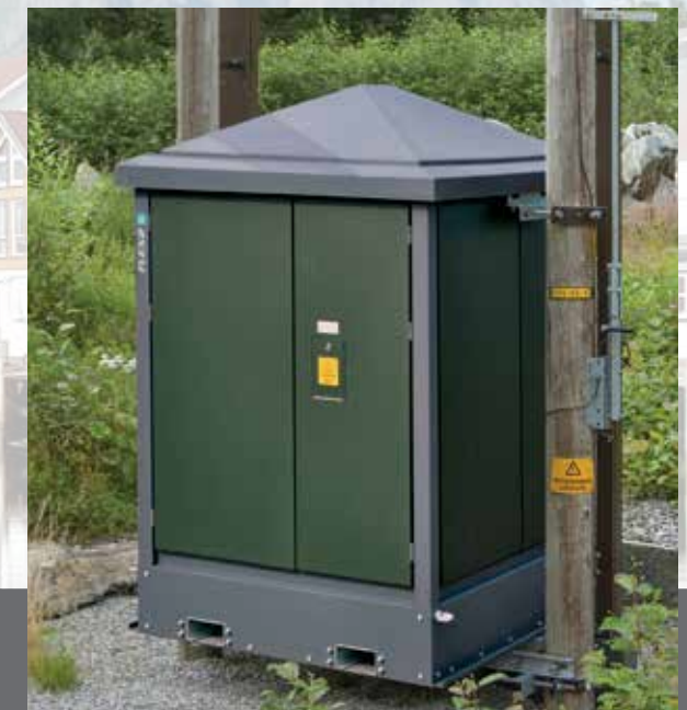
For montering i A- eller H-mast kan FLEX 2 leveres komplett med nedføringskanaler for 3 eller 6 kabler.
