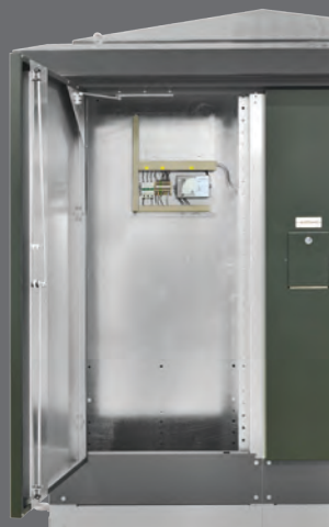
FLEX 3 OG FLEX 10: Egen dør ved siden av LS-døren.
