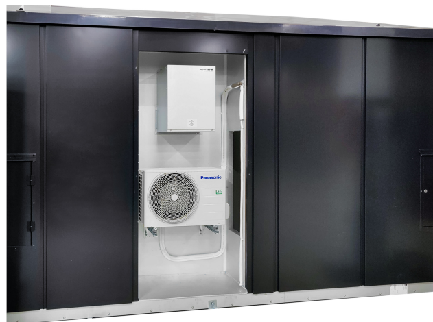
Figur 1.4: Utside av teknikkhus AC nisje, med ventil avmontert.
