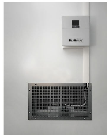
Figur 1.7: Innvendig del av frikjøler, med kontrollenhet.
