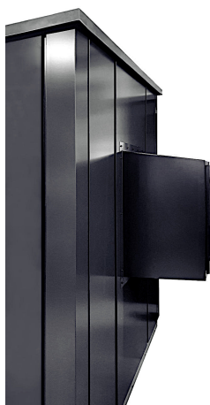
Figur 1.8: Utvendig stormhatt ved inntak.
