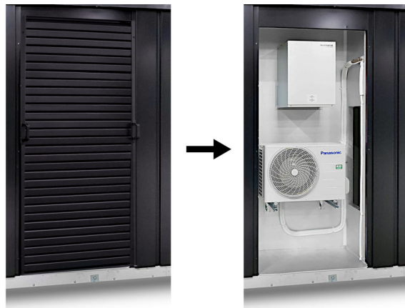
Figur 1.6: Frikjøler og varmepumpe installert sammen i husets AC nisje.
